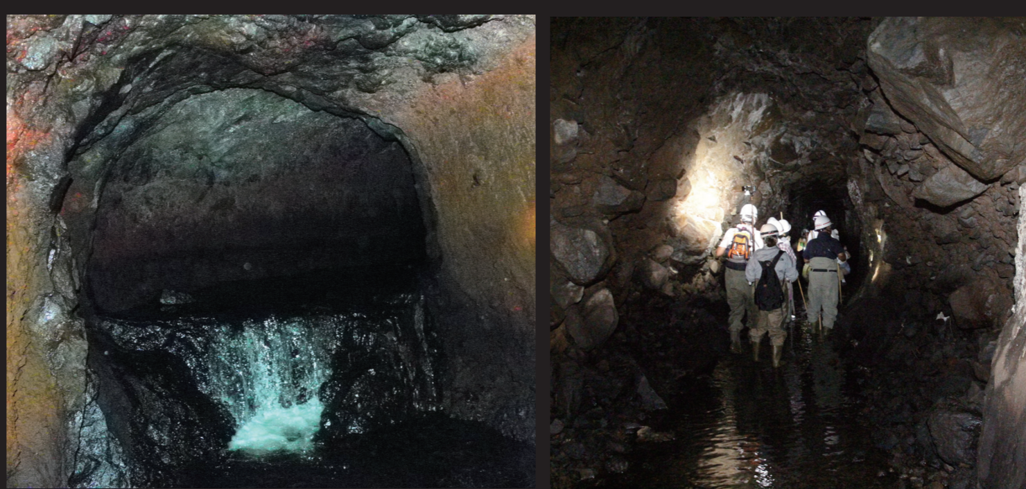
▲ 隧道内部および合流点 左：合流点の高低差は1mほどである。右：隧道内部の様子（『深良用水通水350年記念誌 世界かんがい施設遺産 深良用水の歴史 江戸時代の情熱、郷土を潤す深良用水』2020）
