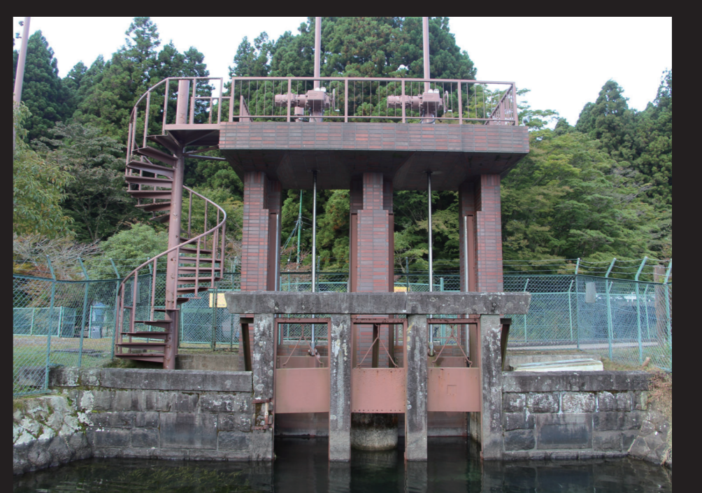
▲ 芦ノ湖（箱根町）側の深良水門。ここから下流80m地点に坑口入口（通称：上穴口）がある。初期水門は芦ノ湖岸から18mの所に杭を打ち、その間に木の枝をからめて「しから」を作り内側に土俵を積み構造。明治43年に石造り・鉄扉に改修。平成元年に旧水門補強・コンクリート製補助水門へ改修し、水門全面に石造水門が残された。
