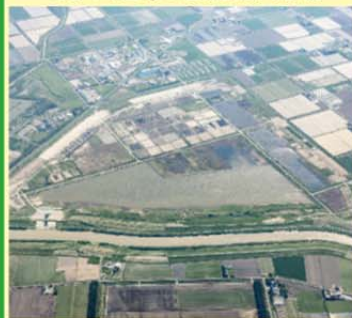
晩翠遊水地建設現場
