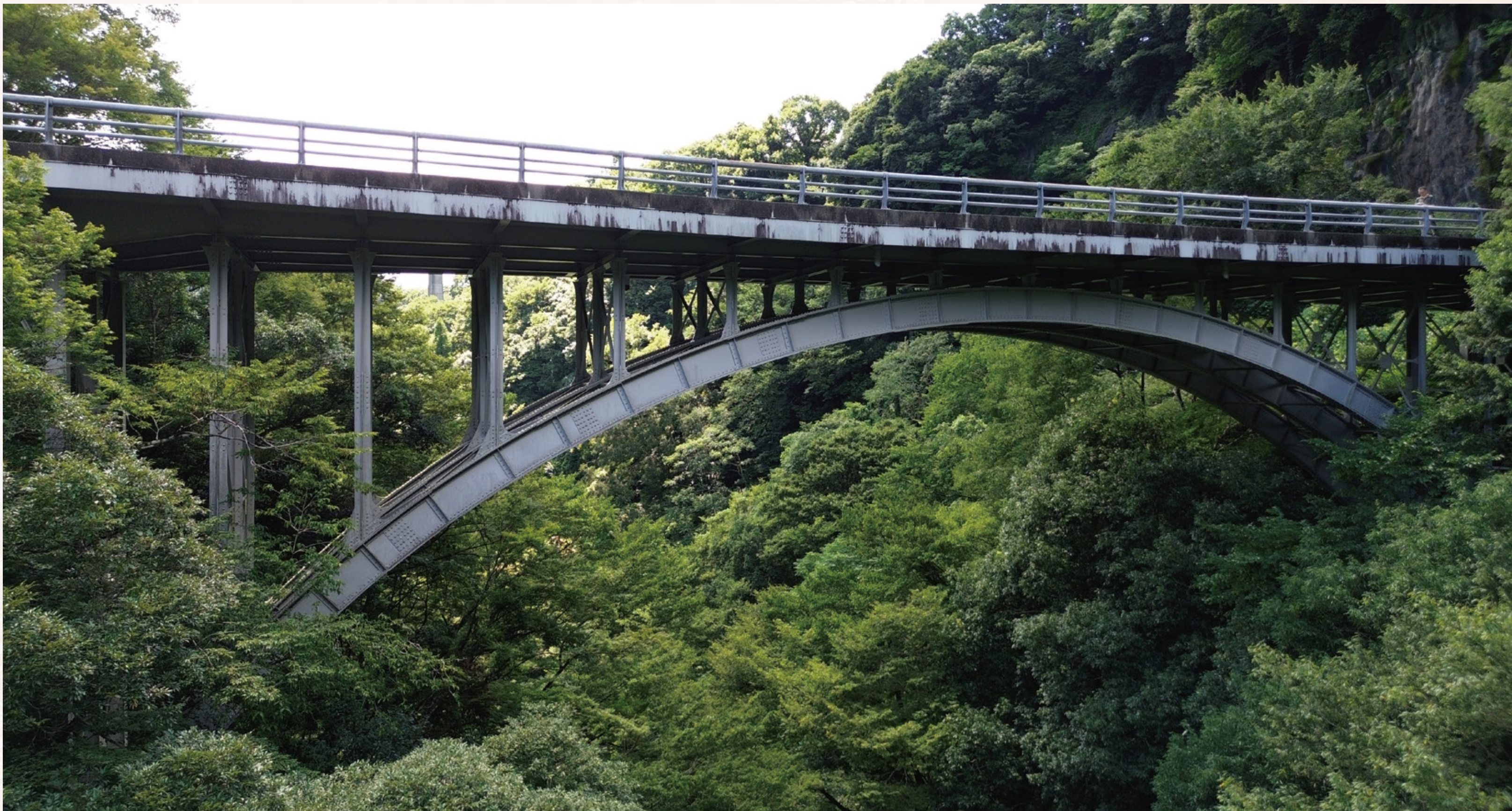
▲鹿狩戸橋全景
