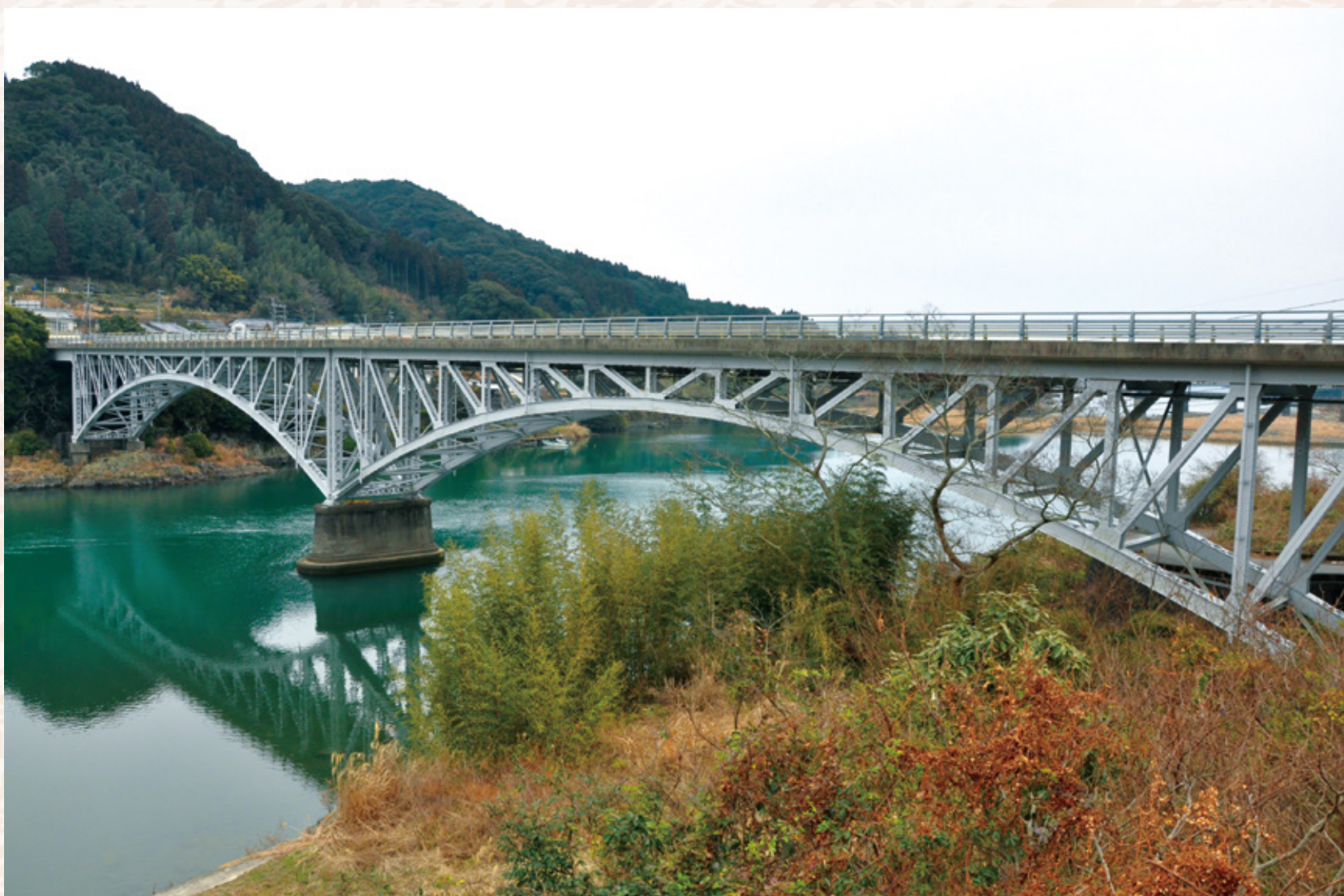
▲1934（昭和9）年に完成した美々津橋
