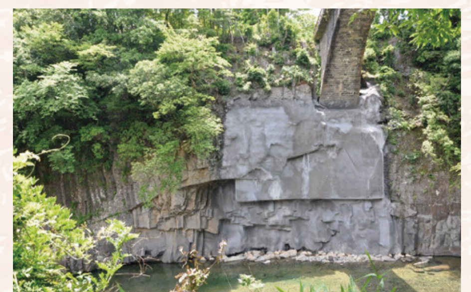
▲アンカー、RCブロックによる修復後の様子
