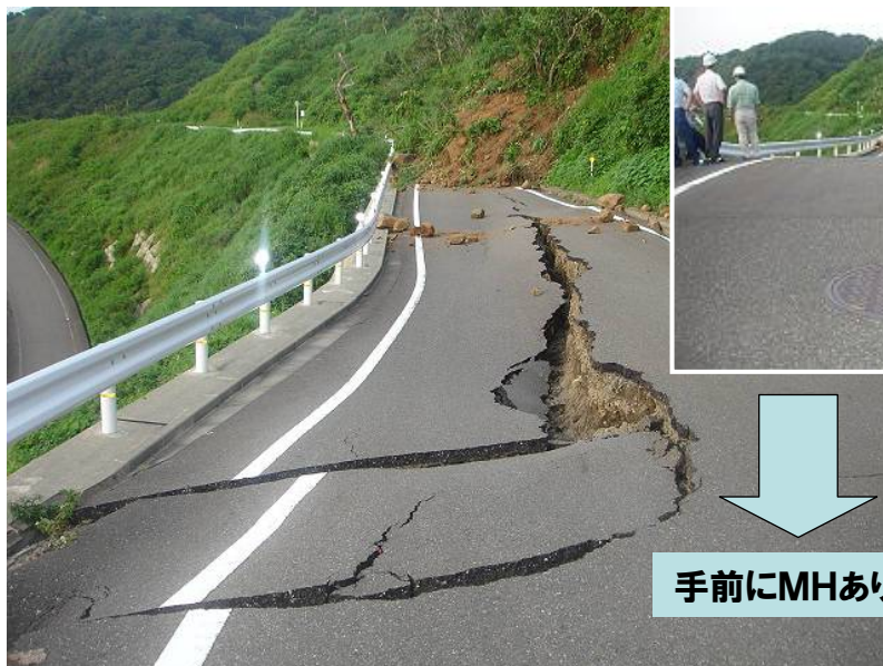
上輪線13MH付近(管路ルート上の道路亀裂)
