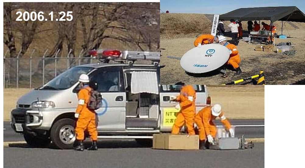
ポータブル衛星端末の設置作業
