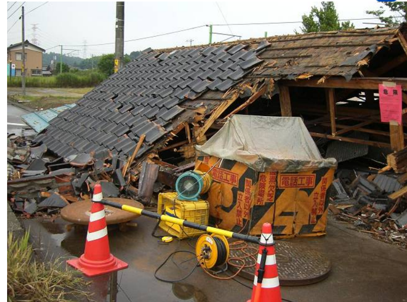
刈羽線32MH(MH上に家屋倒壊)
