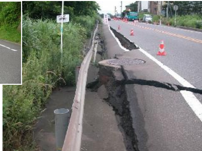
柏崎線20～29MH付近(道路崩壊によるMH露出)
