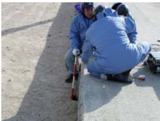
南側突堤 5-6 ケーソン目地部
