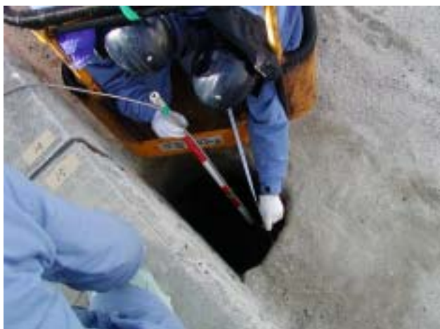
東側突堤 14-15 ケーソン目地部
