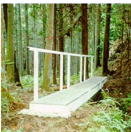
図-2 送電鉄塔巡視路
