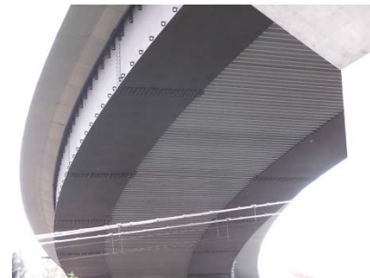
図-8 古間木橋（桁間タイプ）
