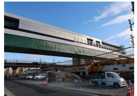
図-9 寺田高架橋（全面タイプ）
