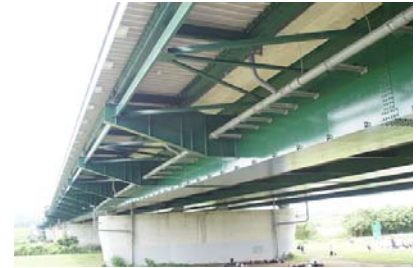
図-6 新木津川橋の下面状況
