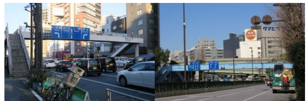
図-6 昭和通りにかかる歩道橋。左は三ノ輪、ページュ系、右は江戸橋南詰、青系。2017年1月
