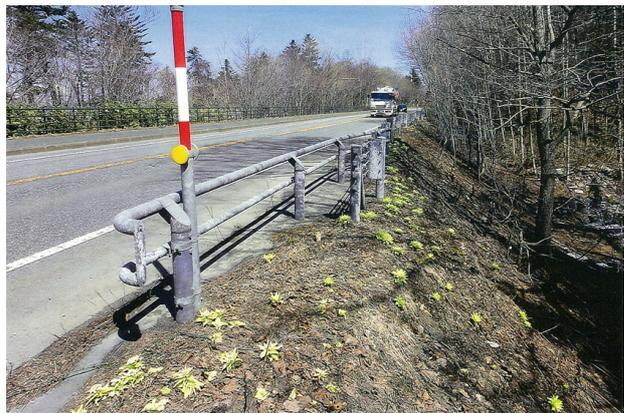
写真-10 リン酸亜鉛処理仕上げの防護柵に発生した白さび
