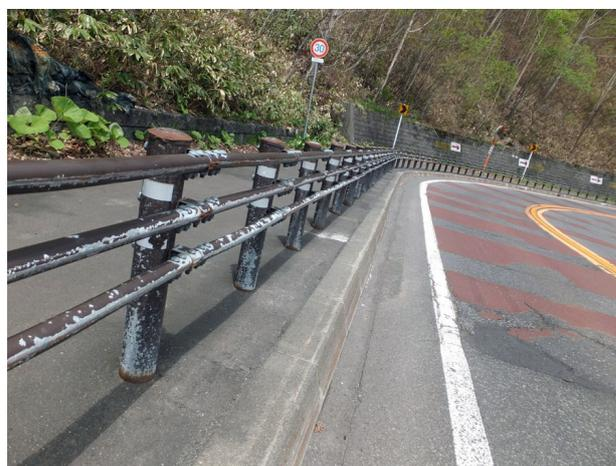
写真7 除雪作業により塗膜が損傷した防護柵
