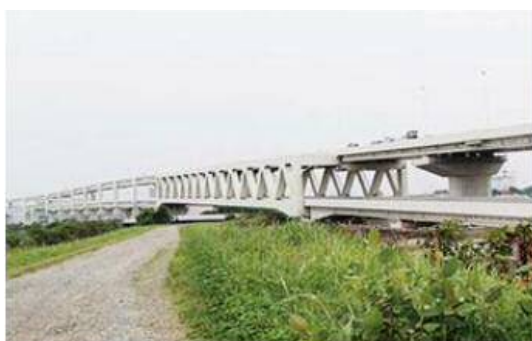
図-4 鶴見川並行部高架橋
