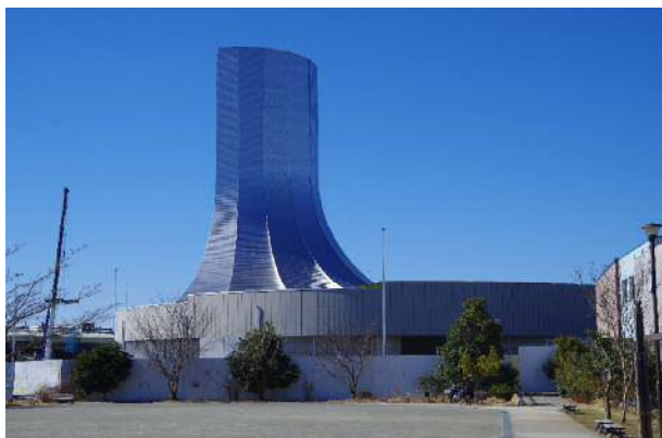
図-17 空に溶け込むと共に、反り屋根の滑らかさを表現するステンレスダル仕上げ
