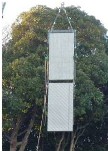
図-30 モックアップによる確認
