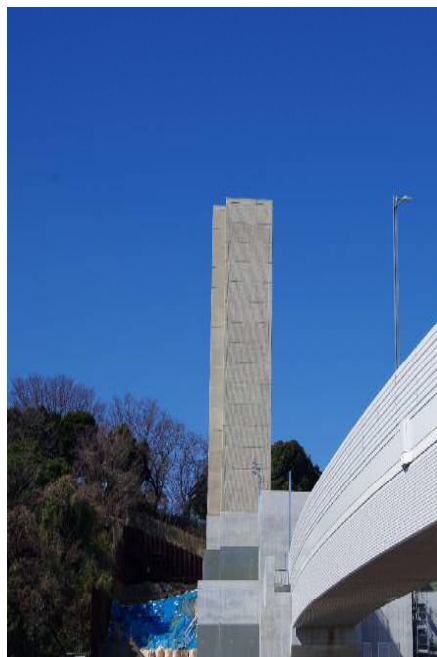
図-31 モックアップによる確認換気塔の面取りによる規模感の低減
