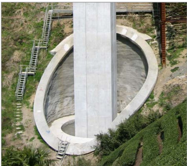
写真-4 竹割土留工法
