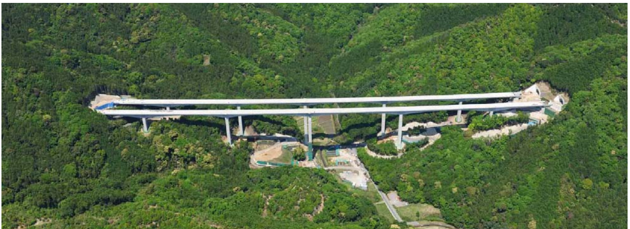
写真-5 工事用道路・ヤードの状況(閉合完了時)
