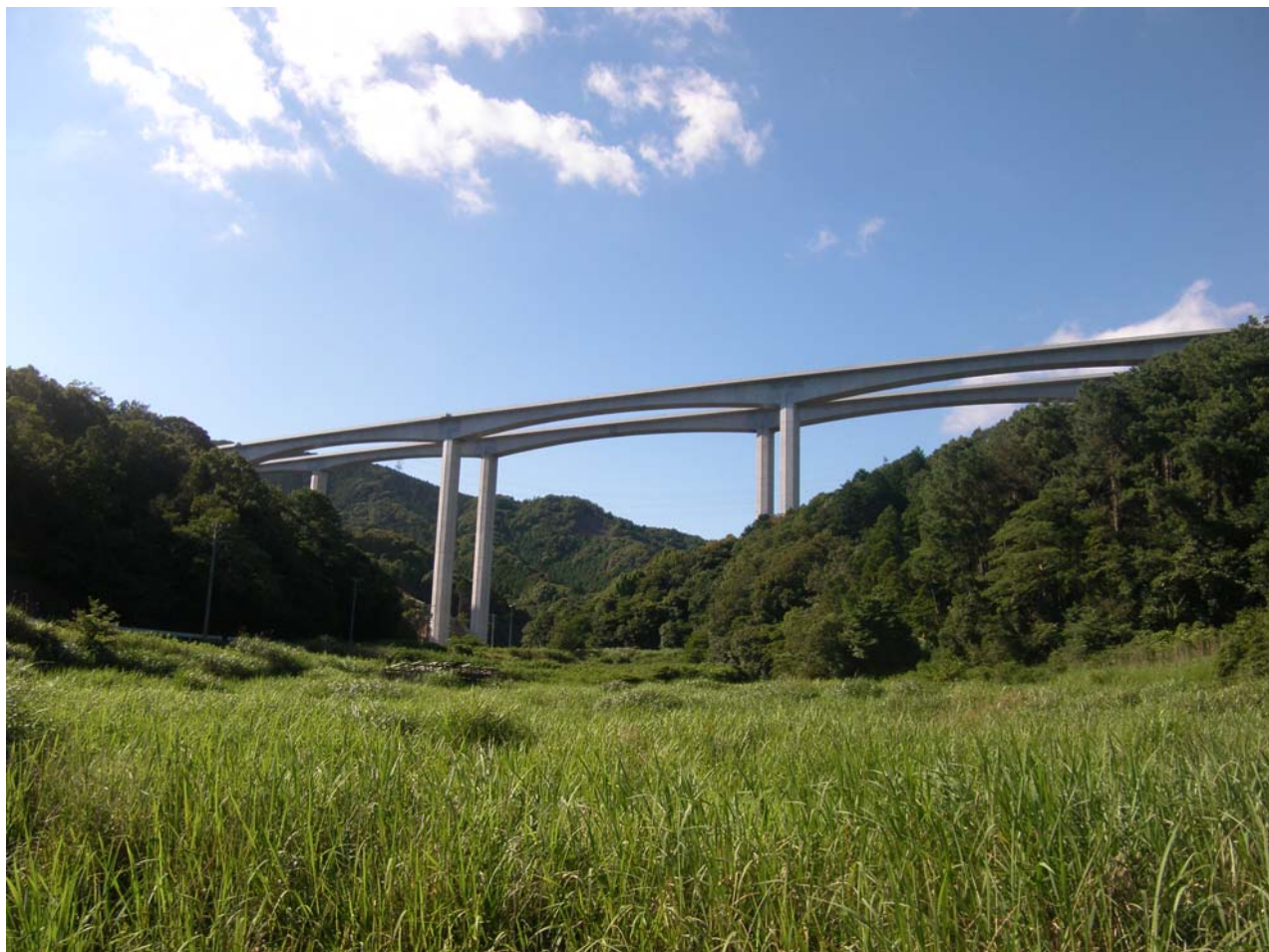
写真-6 完成した新佐奈川橋
