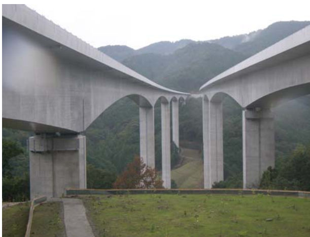
写真-2 橋台部から橋軸方向(橋脚の並び)を見る
