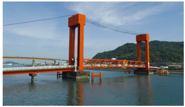
図-6 本渡瀬戸歩道橋
