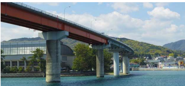
図-5 天草瀬戸大橋
