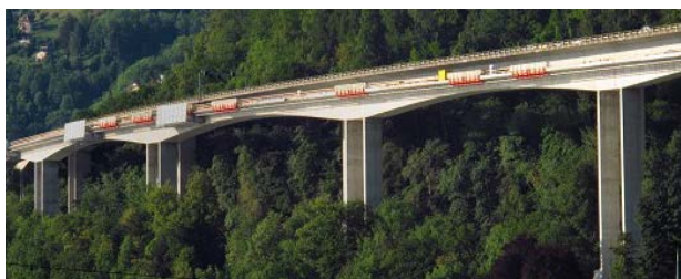
写真-1 chillion 高架橋 4)
