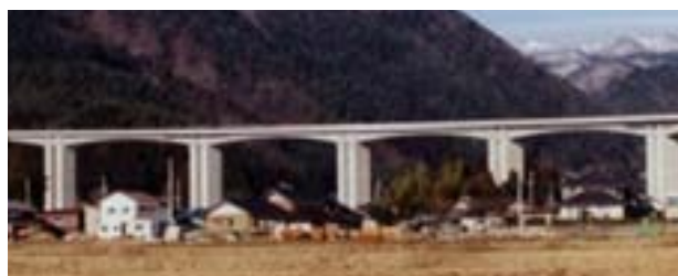
写真-2 中西高架橋 1)
