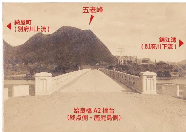
写真-2 竣工当時の始良橋正面写真 (一部赤字加筆) ③
