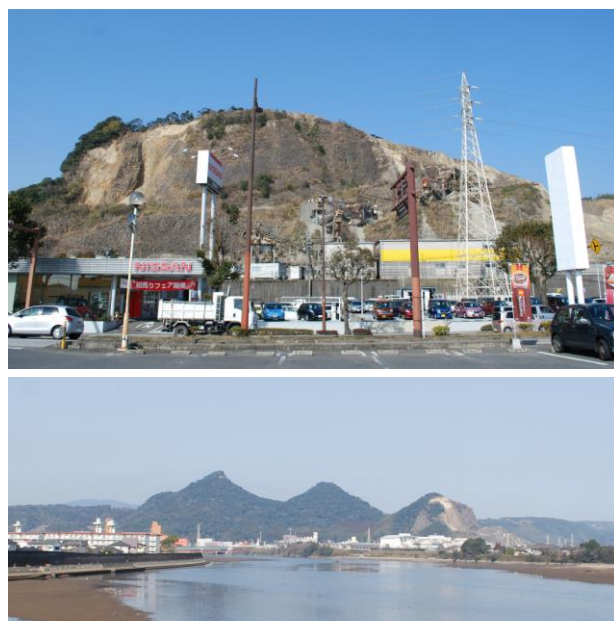
写真-8 現在の五老峰(上:湯湾嶽の砕石状況、下:別府川下流から見た五老峰、右端の峰が湯湾嶽である。ともに2017.1撮影)
