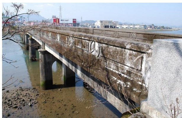
写真-1 現在の始良橋（2013年2月撮影）
