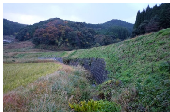
写真-4 伊万里市「木場水路」
