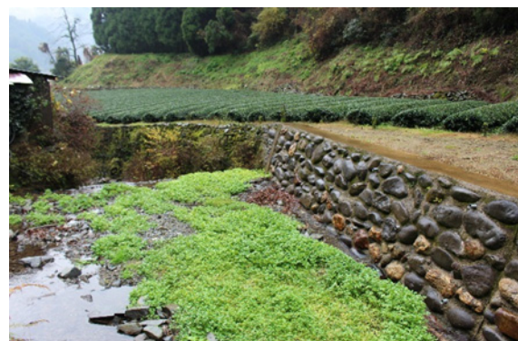
写真-3 八女市「星野川支川」
