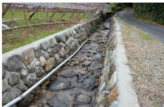
写真-2 久留米市「八幡川」
