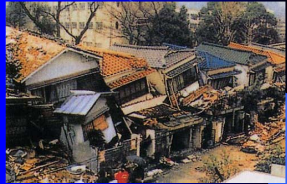
倒壊した家屋
