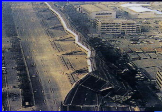
倒壊した阪神高速神戸線
