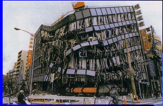
倒壊したビル
