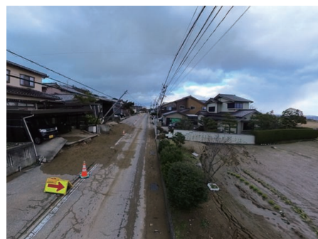
写真7 内灘町西荒屋で生じた液状化に伴う流動による地盤変状 (提供: 石川敬祐)
