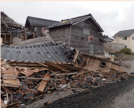
写真1 地震動で被災した建物
