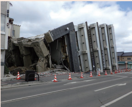
写真2 輪島市の倒壊したビル
