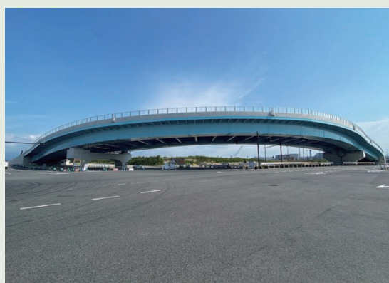
写真1 夢州北高架橋（上：CIMモデル（提供：森組）、下：完成後（提供：日本車輛製造））
