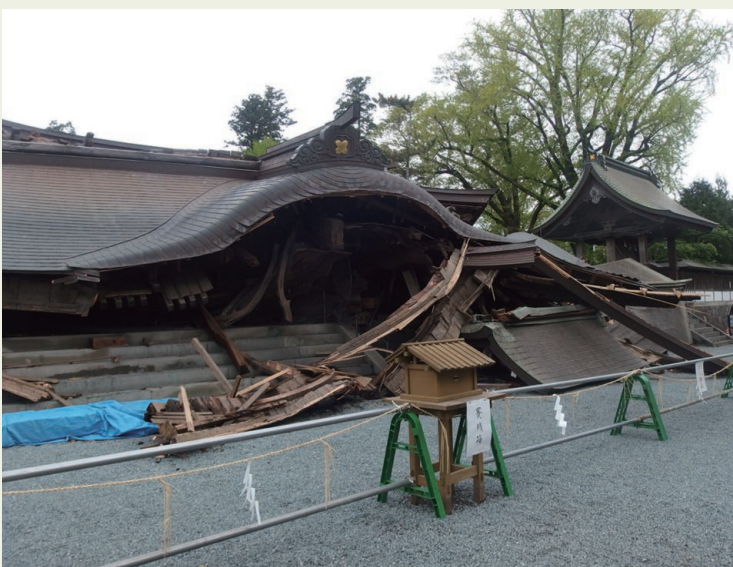
写真2 文化財を含む多くの建物が倒壊した (撮影：NPO法人ASO田園空間博物館)
