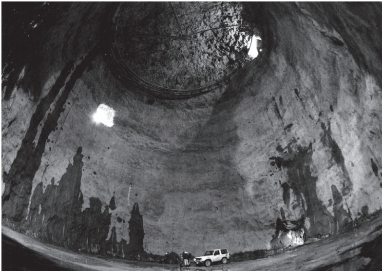
写真1 スーパーカミオカンデ建設中の地下空洞 (提供: 三井金属鉱業(株))
