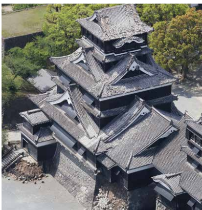
熊本地震/ 瓦や石垣が崩れた熊本城 時事
