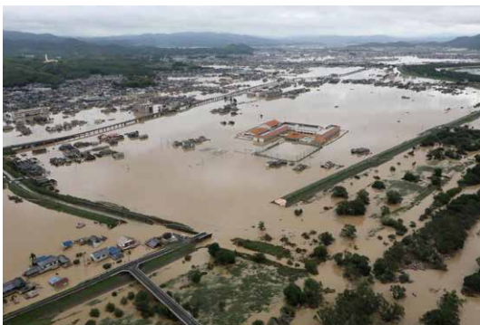
西日本豪雨/小田川の堤防決壊部分
