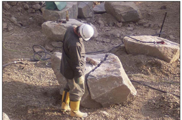
図-13 手仕事による石割状況2
