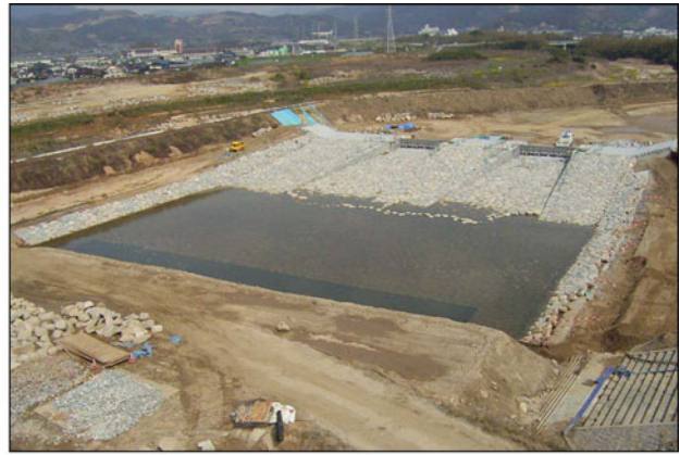
図-15 堰本体石積状況（全景）
