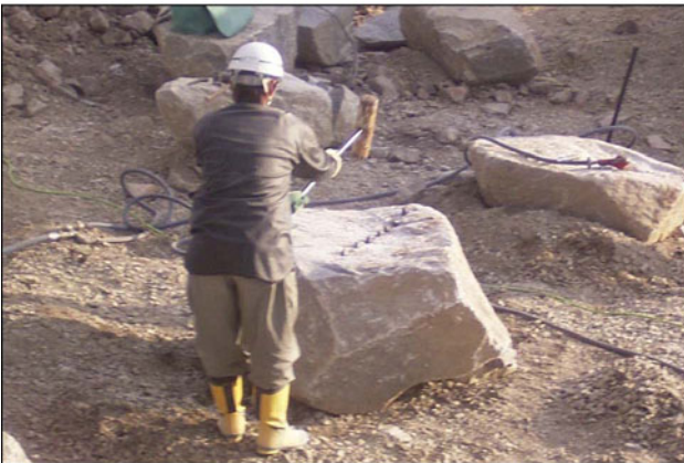
図-12 手仕事による石割状況1
