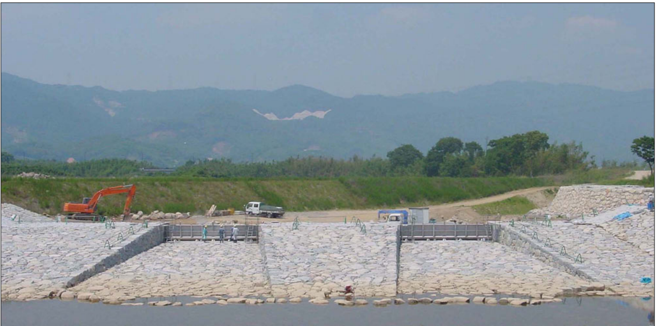
図-4 石井樋大井手堰全景（施工中—前方に見えるのは迂回路の護岸，本線切り直し時に撤去。）
