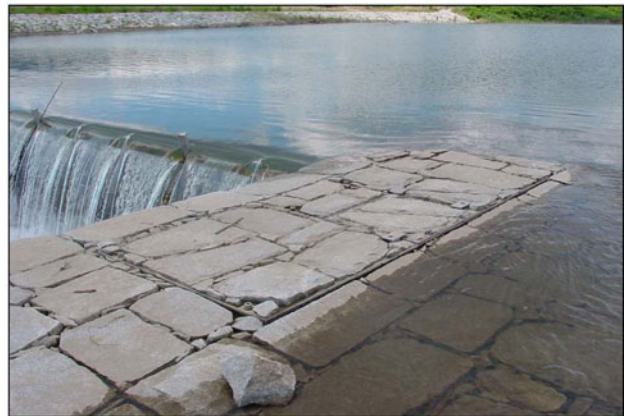
図-19 機械室上蓋（通水後）
