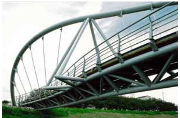
写真-6 桁下から人道橋を見上げる
