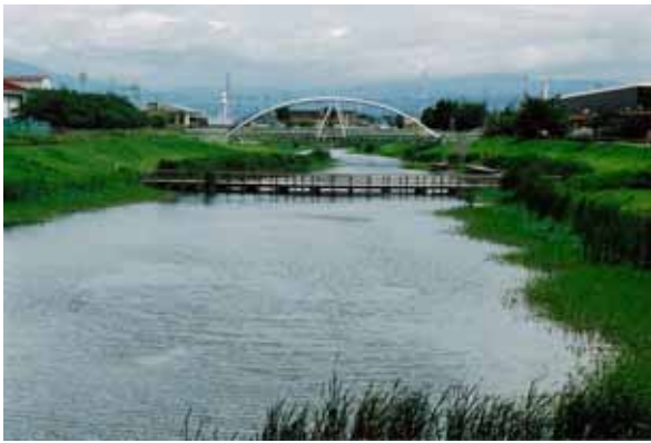
写真-1 まほろば橋（道路橋より）
