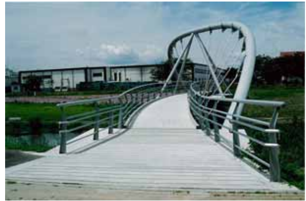
写真-5 人道橋橋詰より
