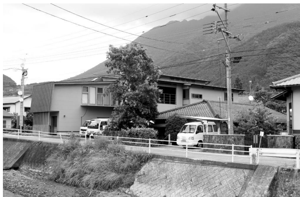
写真-4 高さを10m以下におさえた建築物
