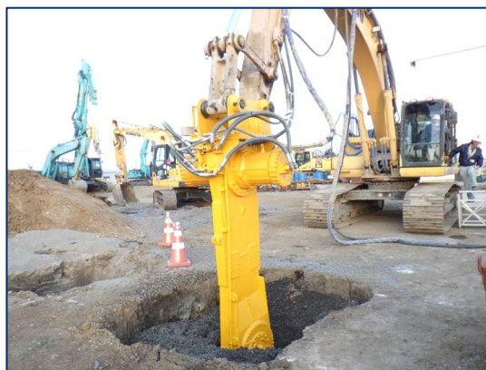
透水性地盤改良体造成の様子
