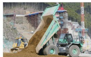
自動ダンプトラックと自動ブルドーザの連携 Cooperative work of automated dump truck and bulldozer
