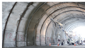
模擬トンネルでの自動吹付けのデモンストレーション Demonstration of automatic concrete spraying
