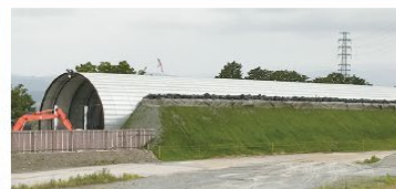
側部覆土後の模擬トンネル Mock-up tunnel after side embankment
