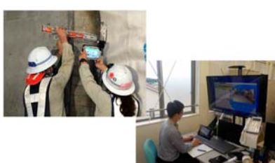
【遠隔立会】遠隔立会による受発注者間の業務効率化
