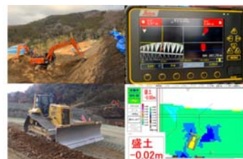
【施工】マシンガイダンス重機による切土・盛土工
