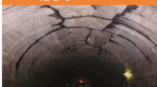
トンネル覆工／高架橋床版など
