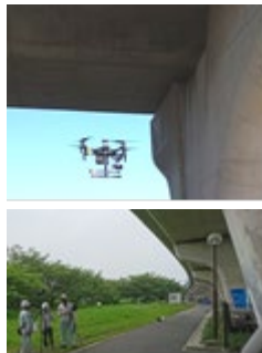
ひび割れの撮影
