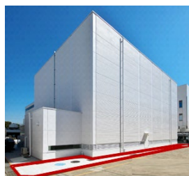
土間コンクリート （赤枠内）
