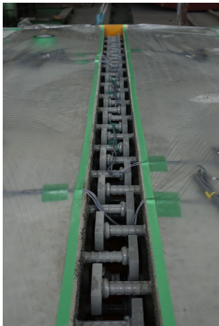
接合部配筋状況
