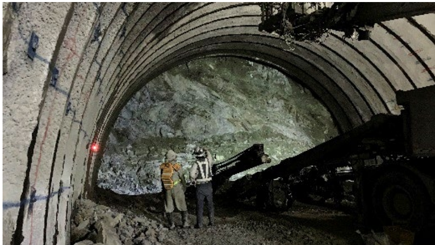
切羽写真の投影による吹付け前の切羽の再現
