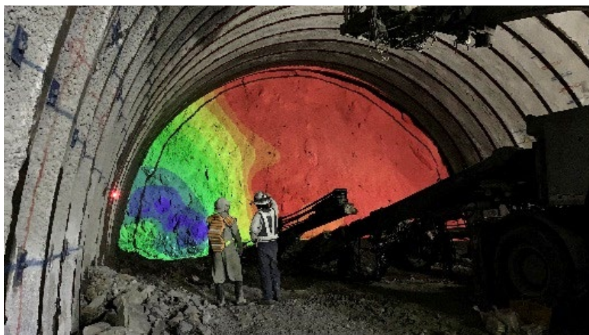
岩盤の硬軟分布を示すカラーコンター図の投影状況
