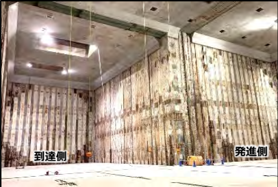
横浜湘南道路 藤沢回転立坑
