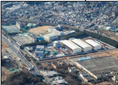
横浜湘南道路 トンネル工事
