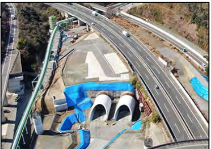
横浜環状南線 釜利谷JCTトンネル工事
