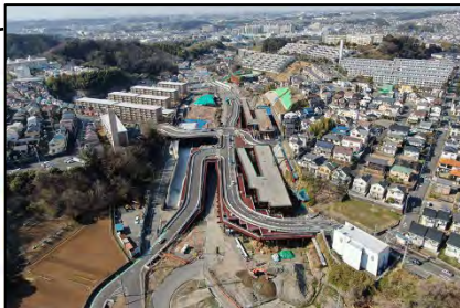
横浜環状南線 公田地区掘削工事
