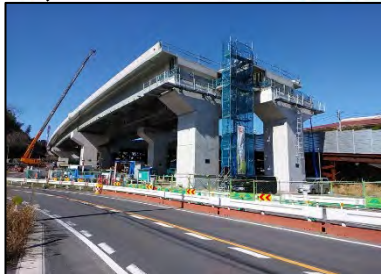
横浜湘南道路 小雀地区橋梁上下部工事
