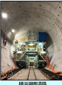
横浜湘南道路 掘進状況(坑内)
