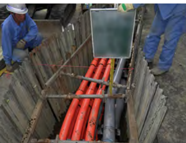
管路部設置状況
