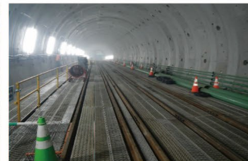
新横浜トンネル施工状況
