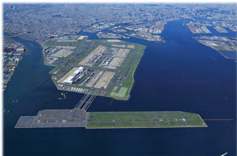
羽田空港(D滑走路方向より)
